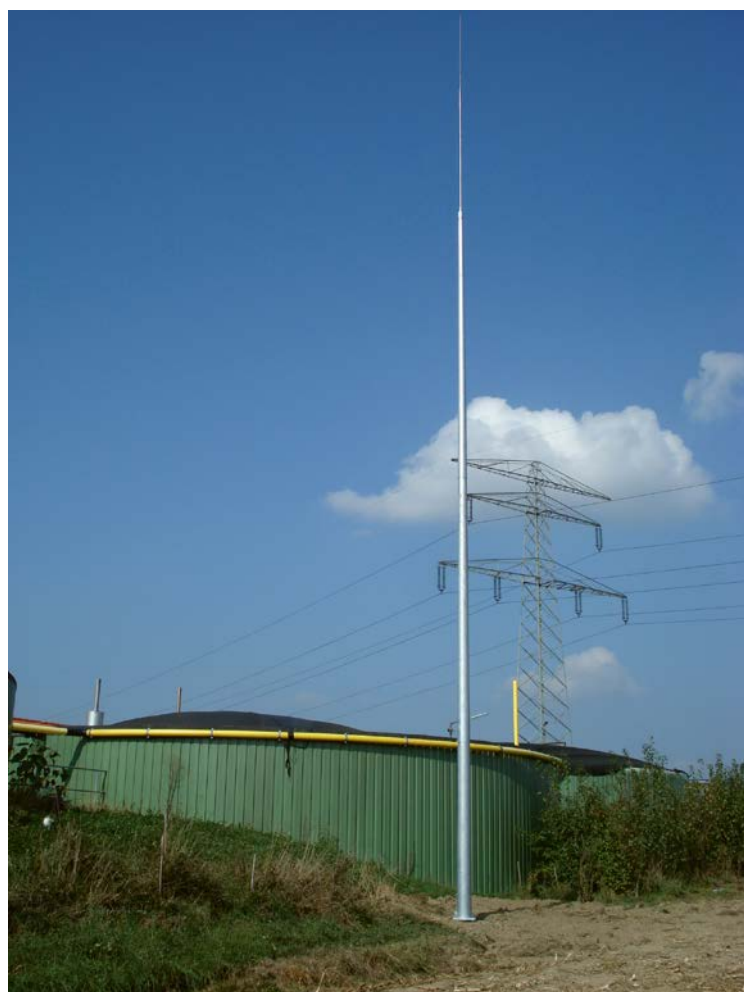
Obrázek 2 Bioplynová stanice s teleskopickým jímacím stožárem
