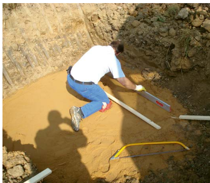
Obrázek 3a Základová jáma s pískovým ložem
